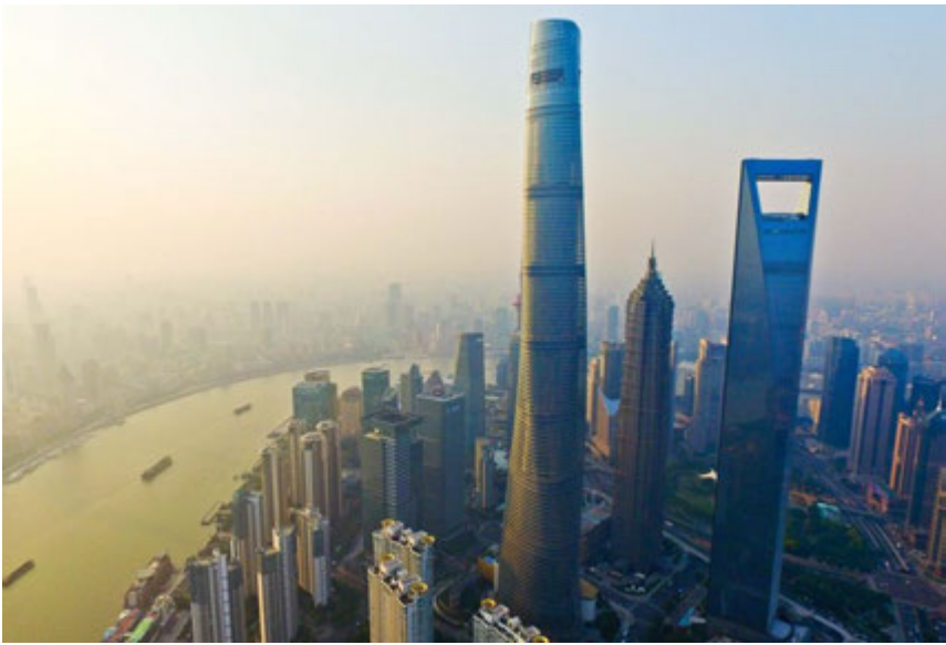
(圖 8) 樓高 632 米的上海中心大廈完工並開放，是世界第二高樓、中國第一高樓，一座集辦公、酒店、會展、商業、觀光等功能於一體的垂直城市。
